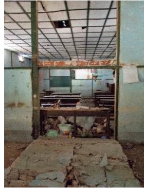
ငလျင်အရှိန်ကြောင့် အဆောက်အအုံ၏ နံရံမှ အုတ်များ ထွက်ကျနေပုံ
